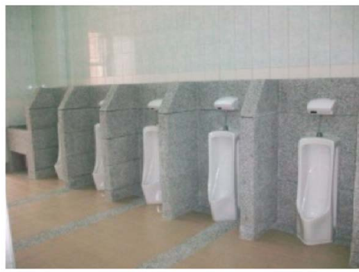
學生廁所改建工程
